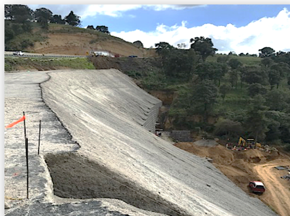
Terraplén a revegetar. Enero, 2019.
